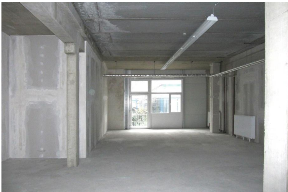
Atelier im Vermietungszustand des veredelten Rohbaus
